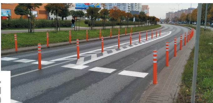
2. Przejście dla pieszych po zamontowaniu słupków odbłaskowych o: opracowanie własne
