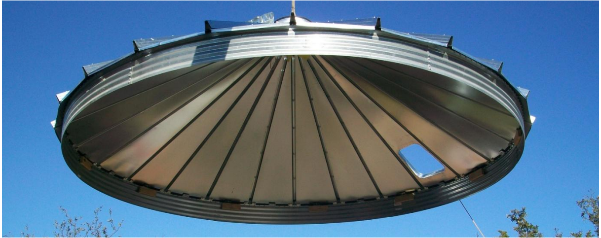
Rys. 3.10. Konstrukcja dachu bezkrokwiowego [16]
