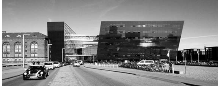
Fot. 3. Biblioteka Królewska w Kopenhadze. Widok od strony Soren Kierkegaard Plads
