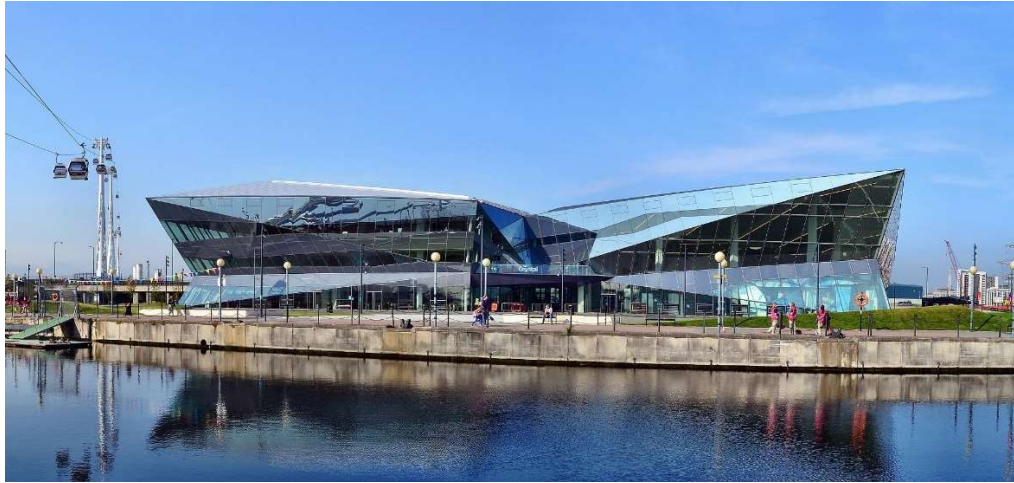
Fot. 1. Pochylenie ścian elewacyjnych obiektu „The Crystal” (Wilkinson Eyre Architects z Arup Group Limited i z Townshend Landscape Architects) pozwala na zacienianie cieniem własnym budynku różnych fragmentów elewacji w ciągu dnia
