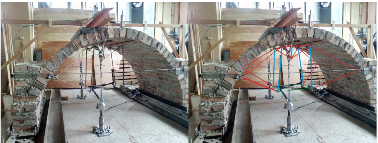
Rys. 78 Badane sklepienie w skali technicznej (zdjęcie oraz zdjęcie z uwidocznionym schematem kratownicy tensegrity).
