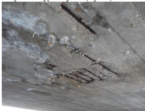
Rys. 3. Spód płyty pomostu
