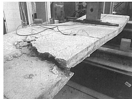
Rys. 9. Płyta nr 3 po zniszczeniu
