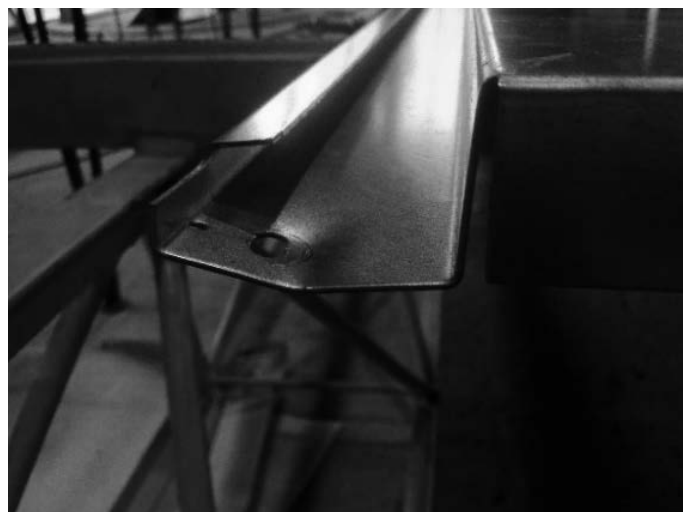
Rys. 8. Deformacje plastyczne w okolicach łącznika przy obciążeniu ssaniem wiatru (fot. P. Lewandowski)
