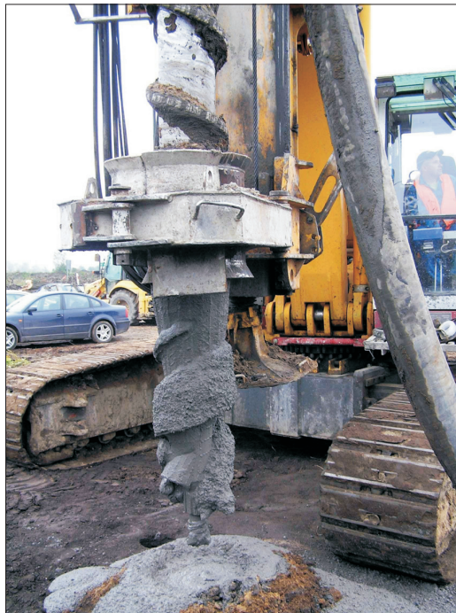
Rys. 5. Świder SDP \phi 356 mm: a) widok, b) w czasie pracy Fig. 5. The SDP auger of 356 mm diameter: a) view, b) during work
