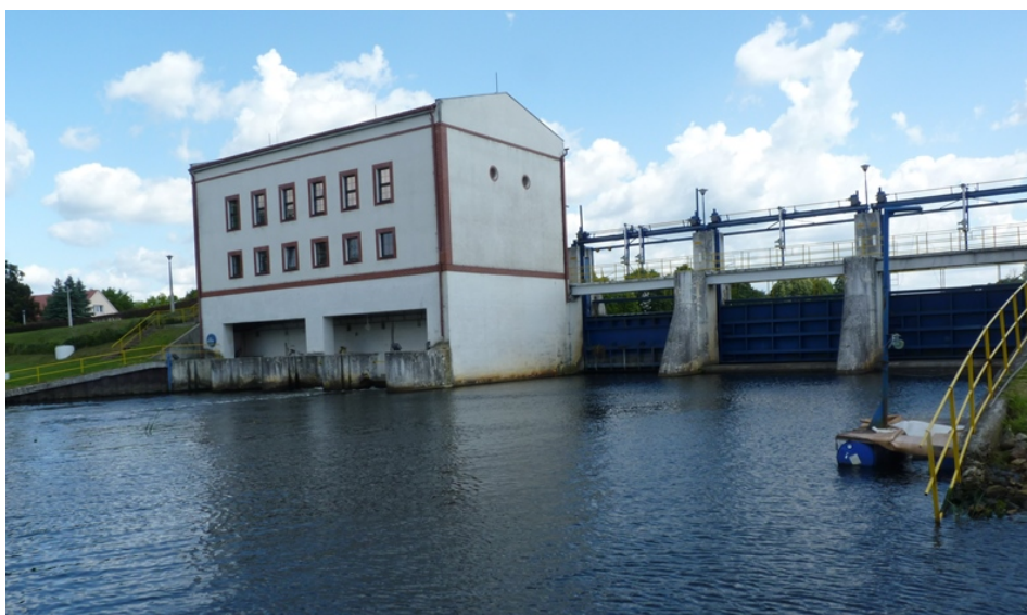
Rys. 2. Elektrownia wodna i jaz w widoku od strony dolnego stanowiska Fig. 2. Hydropower and weir – downstream view
