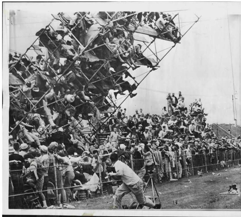
Fot. 1.1 Awaria trybuny metalowej wznoszonej za pomocą systemu rusztowań w Indianapolis w 1960 roku ( http://sports.usatoday.com ).
