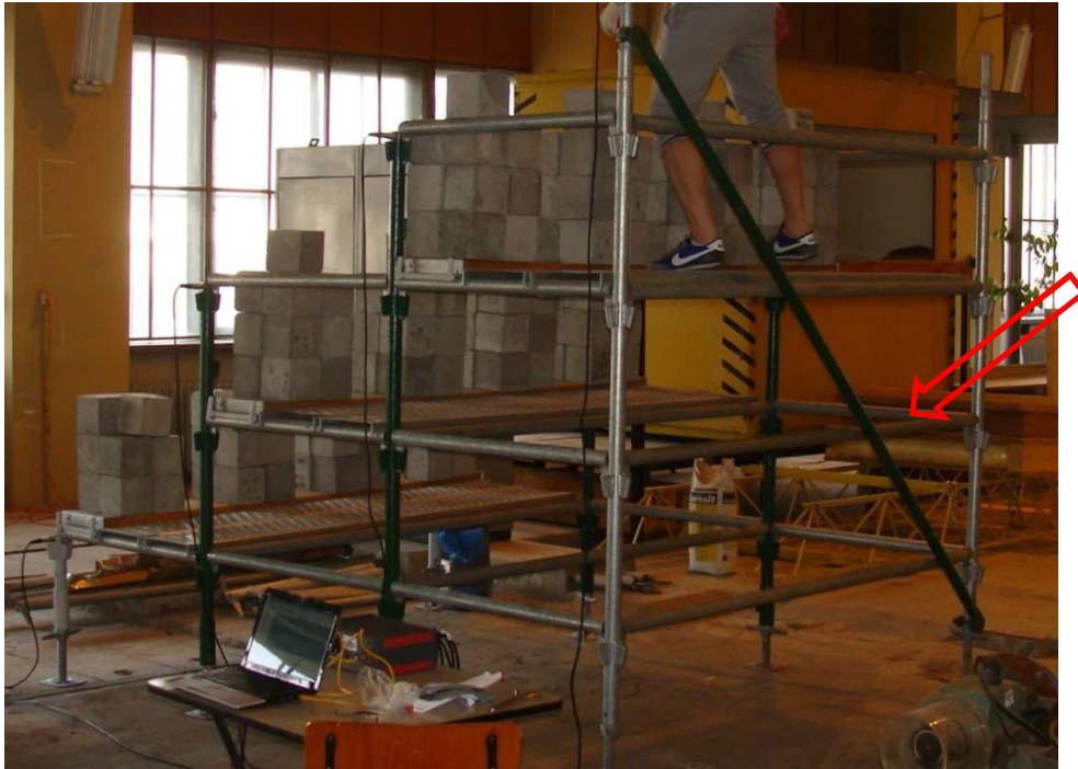
Fot. 5.5 Tymczasowa trybuna stalowa wyposażona w rurowy element stężący.
