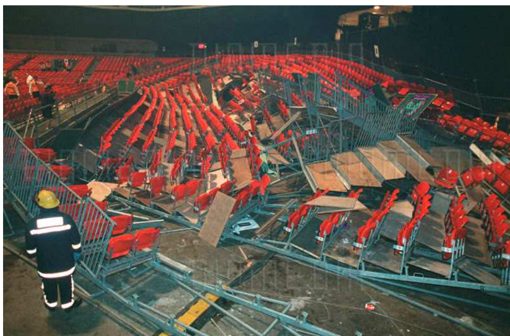
Fot. 1.5 Awaria tymczasowej konstrukcji trybuny stalowej w Londynie w 1994 roku ( https://www.diomedia.com ).
