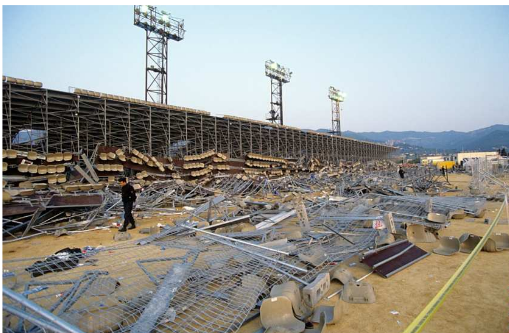
Fot. 1.3 Awaria tymczasowej konstrukcji trybuny na Korsyce w 1992 roku ( http://www.stadiumguide.com ).
