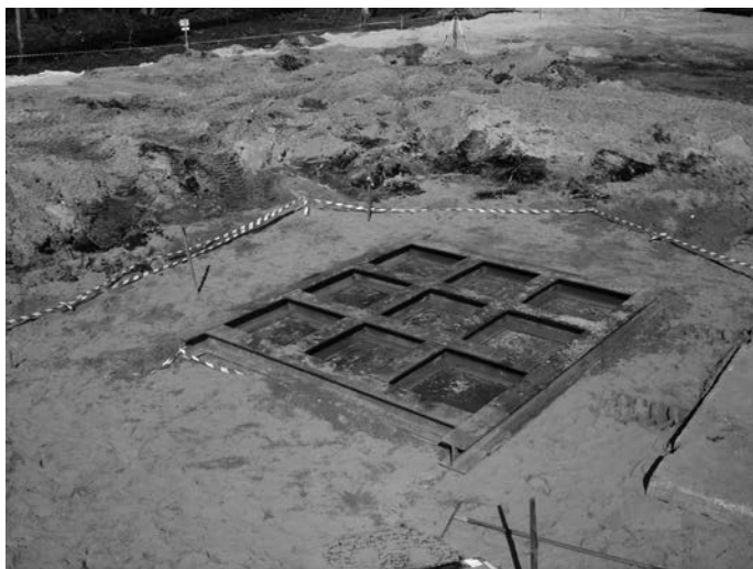
Rys. 5. Podstawa konstrukcji obciążającej kolumnę z kruszywa
