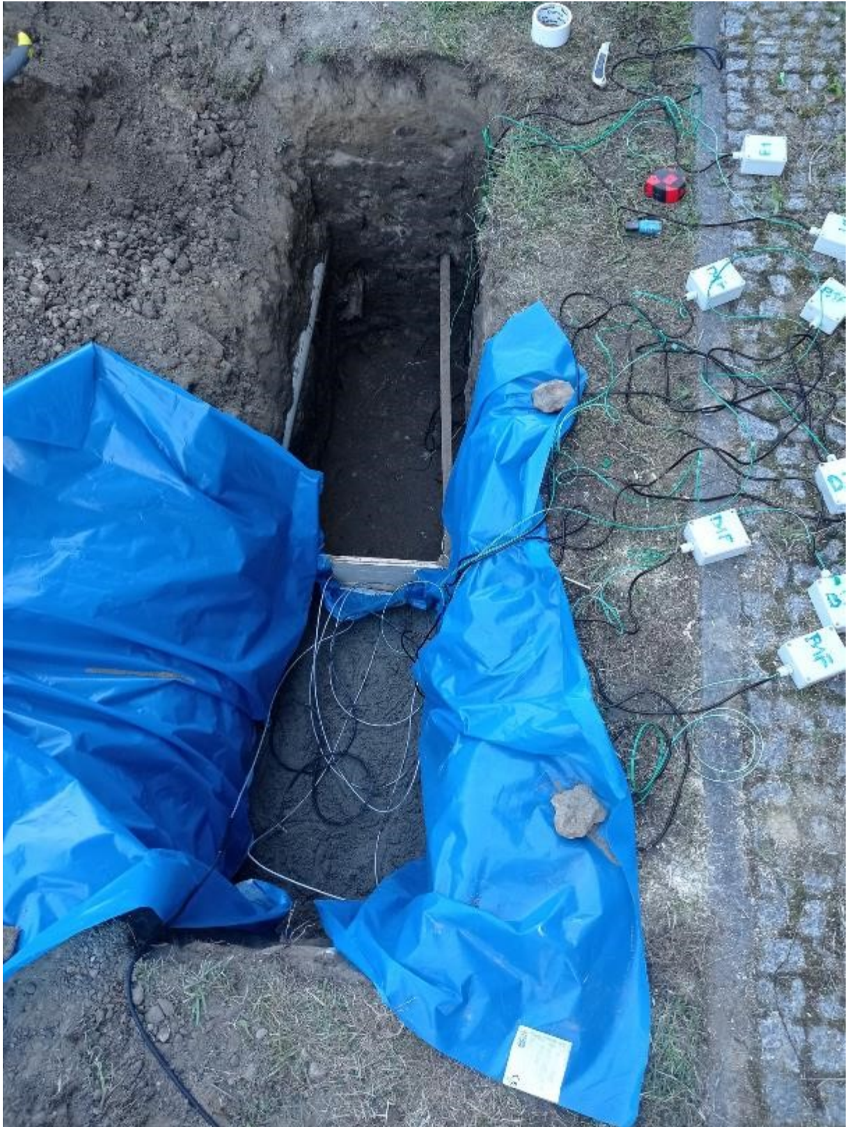
Rysunek 43. Proces wypełniania betonem odcinka ułożonego w folii paroizolacyjnej
