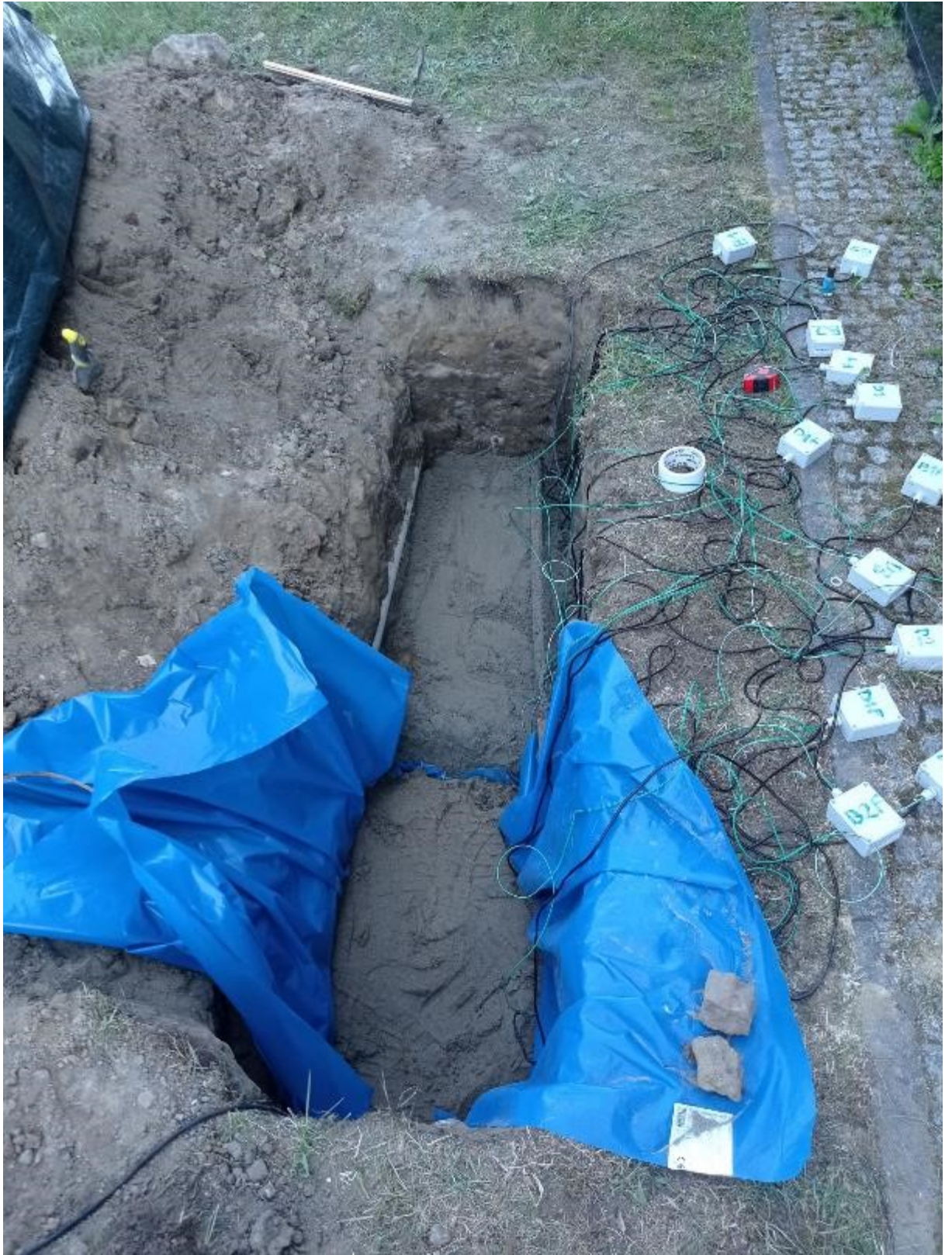
Rysunek 45. Zakończenie umieszczania betonitu
