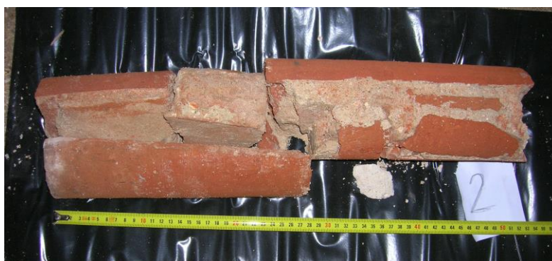
Rys. 8 Pęknięty odwiert rdzeniowy pobrany do badań ze ściany XII wiecznego kościoła (fot. Tomasz Majewski)
