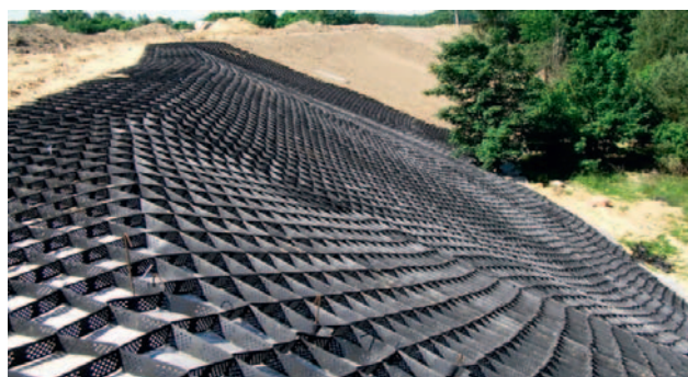
Fot. 6. Geosyntetyk komórkowy
