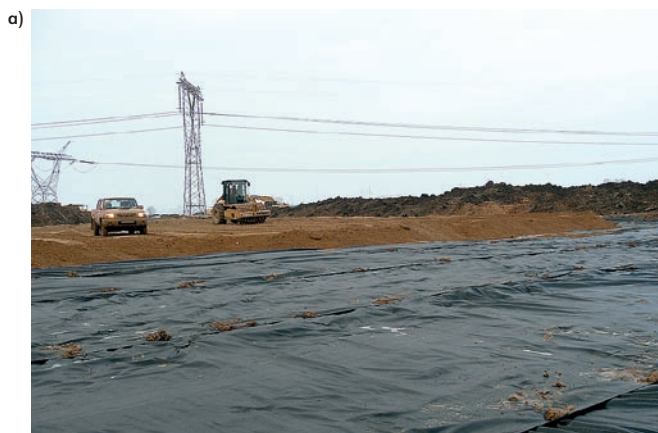
Fot. 1. Proces wykonywania platformy roboczej: ułożenie geotkaniny i rozścielenie warstwy piasku
