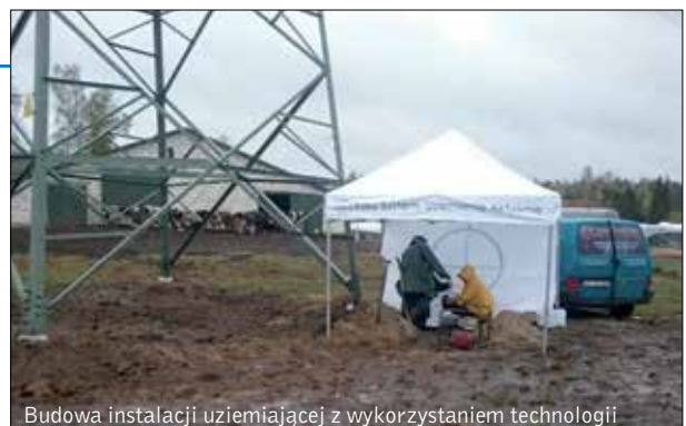
Budowa instalacji uziemiającej z wykorzystaniem technologii
