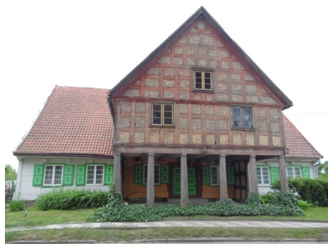
Fot. 13. Dom podcieniowy w Lubieszewie (fot. autor)
