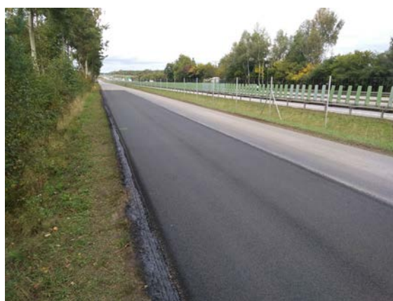
Figure 19. Galaktyczna test section after completion.
