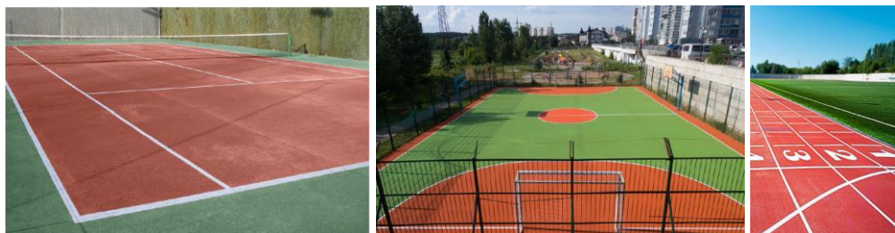
Rysunek 5. Zastosowanie betonu PERVIA w obiektach sportowych.
