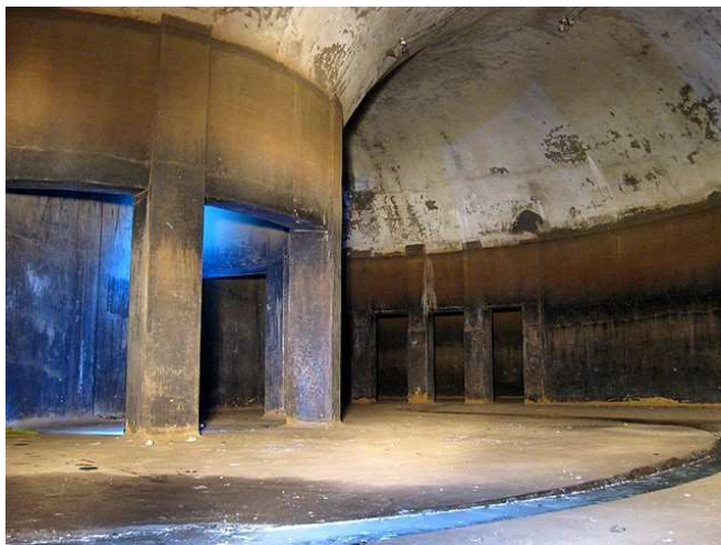
Rys. 3. Komora K1, wewnętrzny pierścień zbiornika i serce obiektu
