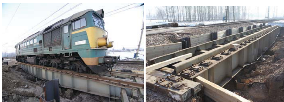
Rys.2. Widok ogólny konstrukcji odciążającej KO84
