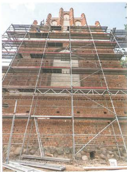
8. Barczewo. Kościół Świętego Andrzeja. Elewacja wschodnia w trakcie prac konserwatorskich, podczas rekonstrukcji zwieńczenia szczytu, 2022 roku. Fot. Damian Kwiecień – Gorek Restaura.
