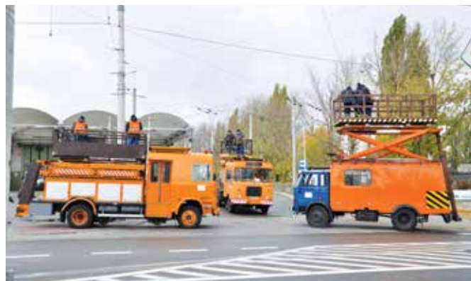
Fot. 24. Trzy pojazdy wieżowe (od lewej Mercedes-Benz, Škoda i Star) należące do spółki INEX z Gdańska, wykorzystywane do przebudowy sieci trakcyjnej w okolicy zajezdni trolejbusowej w Gdyni. Fot. K. Grzonka
