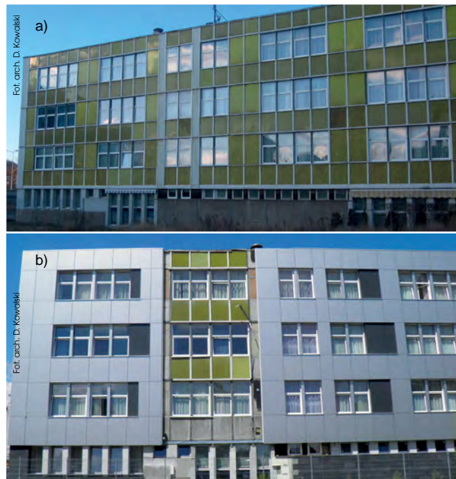
Rys. 4. Budynek hotelowy z lat 70. ubiegłego wieku: a) obiekt przed renowacją z systemową lekką elewacją z okresu budowy typu Bistyp, b) w trakcie renowacji w roku 2016
