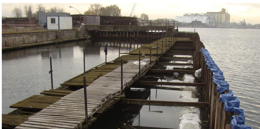
Rys. 2 - Widok komory wschodniej doku i grodzi zewnętrznej od strony Kanału oraz bramy wschodniej doku i Nabrzeża Przemysłowego przed rozpoczęciem robót rozbiórkowych. Fot. własna
