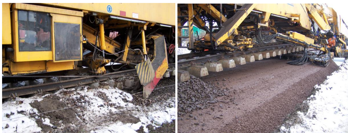
Rys. 4. Wybieranie warstwy podtorza (z lewej) i wbudowanie warstwy wzmocniającej (z prawej)
