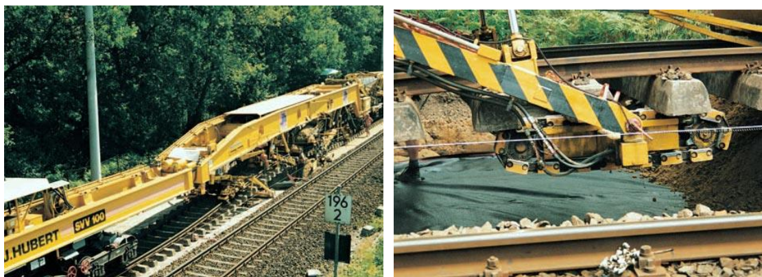
Rys. 10. Schemat maszyny SVV100 oraz widok układanego wzmocnienia[2]
