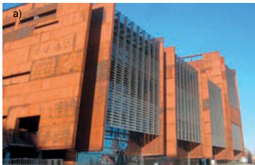
Rys. 9. Przykład zastosowania okładziny ze stali typu Cor-Ten, o podwyższonej odporności na warunki atmosferyczne, na budynku ECS w Gdańsku: a) fragment elewacji budynku, b) składowana blacha elewacyjna z widocznymi zawieszami
