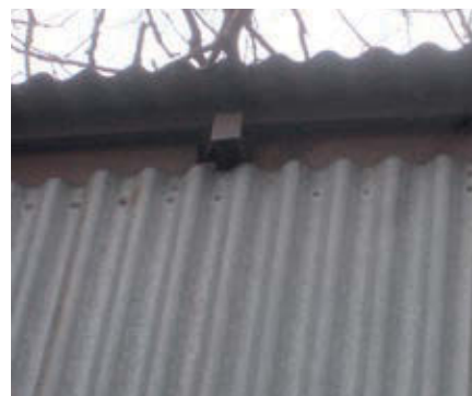
Rys. 6. Stalowa blacha ocynkowana na ścianach i dachu obiektu magazynowego
