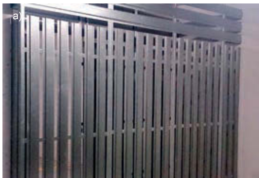
Rys. 11. Przykłady lekkich przegród budowlanych z materiałów metalowych
