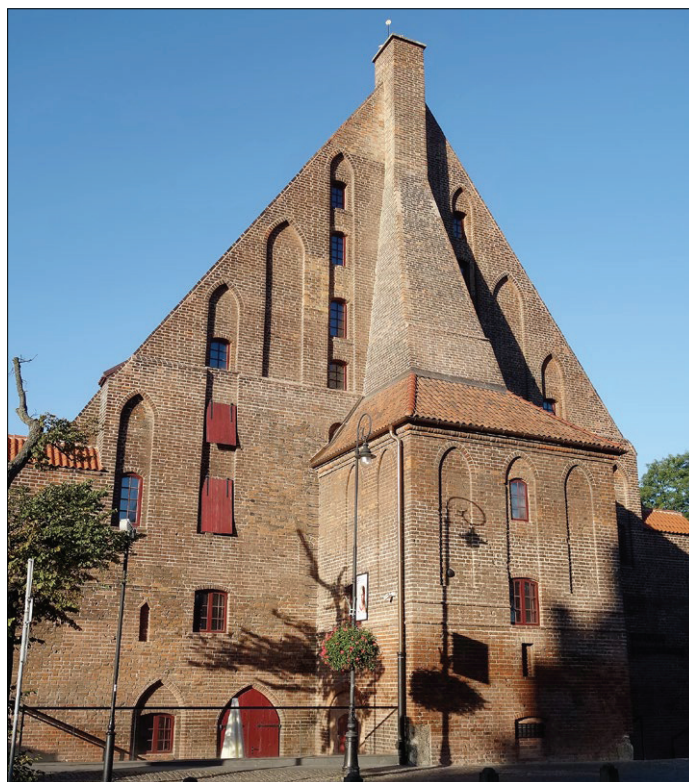
Ryc. 10. Elewacja wschodnia po pracach rewaloryzacyjnych i wykonaniu nowej stolarki, 2021 r.
