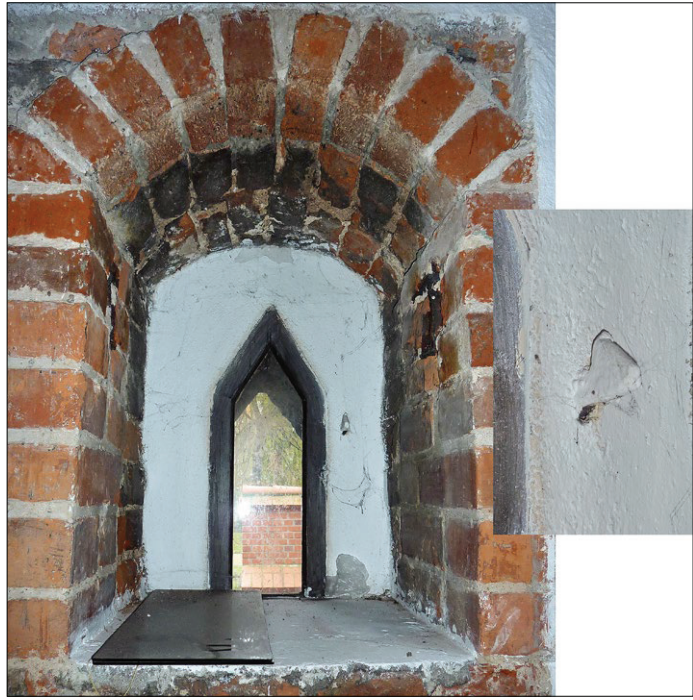
Ryc. 2. Okienko w elewacji południowej oraz hak od skobla do zamykania okiennicy; autorem wszystkich współczesnych fotografii i rysunków jest K. Darecka Fig. 2. Small window in the south facade and the hook for the staple for closing the shutter; all contemporary photos and drawings by K. Darecka
