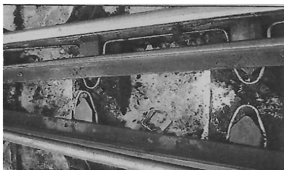
Rys. 1. Ilustracja systemu wodnego ogrzewania rozjazdu kolejowego [3]
