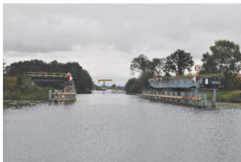
c) Most kolejowy w Rybinie
