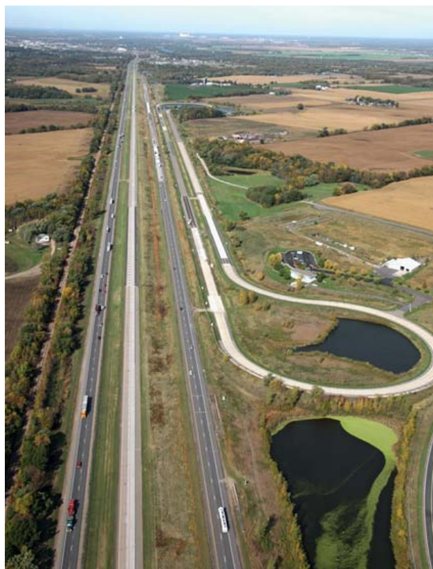
Rys. 5. MnRoad Facility w stanie Minnesota, USA. Widok na tor doświadczalny Mainline – trzecia nitka autostrady, licząc od lewej strony, oraz na LVR – tor w kształcie spłaszczonego w środkowej części okręgu. Na rysunku widoczny jest również by-pass (druga nitka autostrady od strony lewej) wykorzystywany w okresach zamykania dla ruchu toru Mainline. Na rysunku nie jest widoczny tor Farm Loop, który jest zlokalizowany w dół od dolnej krawędzi zdjęcia. Zdjęcie wykorzystane za zgodą MnDOT
