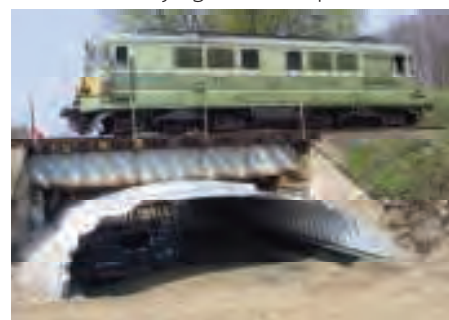
1. Przebudowa obiekt belkowego na gruntowo-powłokowy
