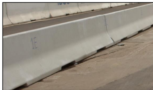
Rys. 2.12 Bariera z prowadnicą betonową
