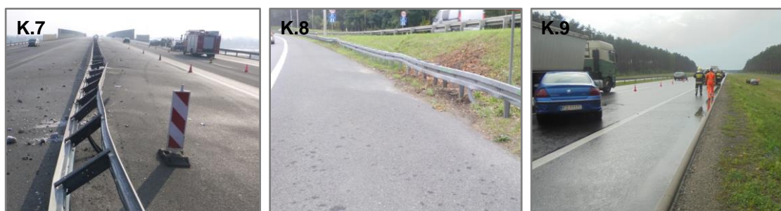
Rys. 5.11 Grupy zdarzeń K.7-K.9 wywołane najechaniem pojazdu na barierę ochronną
