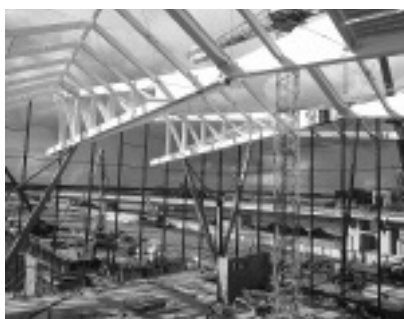
Fot. 1. Konstrukcja stalowa Terminalu Photo 1. The steel structure of the Terminal
