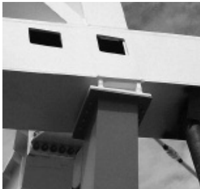
Fot. 2. Połączenie dźwigara dachowego ze słupem
