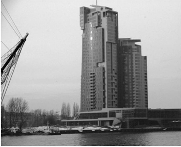
Ryc. 3. Apartamentowce Sea Towers przy Nabrzeżu Prezydenta (fot. M. J. Sołtysik, styczeń 2011)
