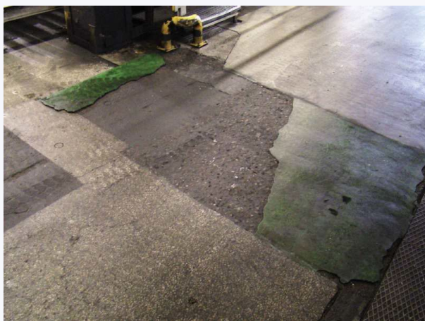
FOT. 2-3. Uszkodzenia posadzki betonowej w hali konfekcjonowania olejów i produktów ropopochodnych, w której poruszały się ciężkie wózki widłowe; fot. arch. autorów
