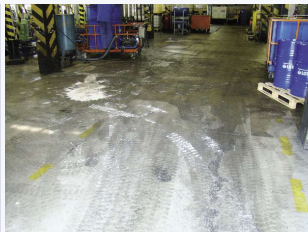
FOT. 2-3. Uszkodzenia posadzki betonowej w hali konfekcjonowania olejów i produktów ropopochodnych, w której poruszały się ciężkie wózki widłowe; fot. arch. autorów
