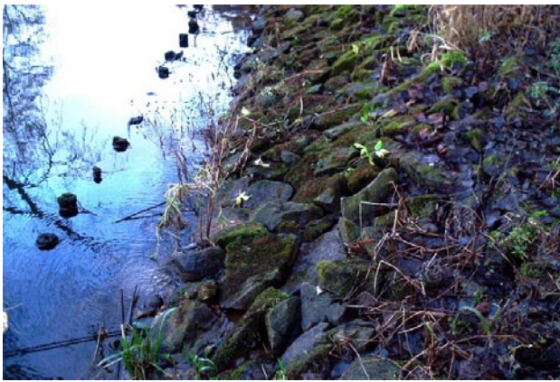
Rys. 7. Umocnienie brzegu narzutem kamiennym – schemat istniejącej konstrukcji
