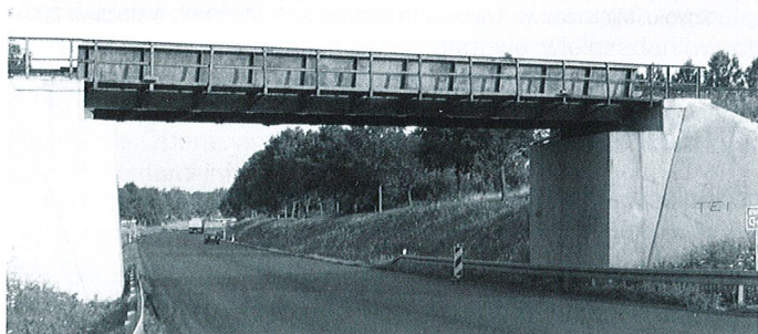
Rys. 1. Widok wiaduktu od strony Warszawy
