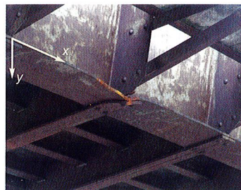
Deformacje pionowe krawędzi pasa dolnego
