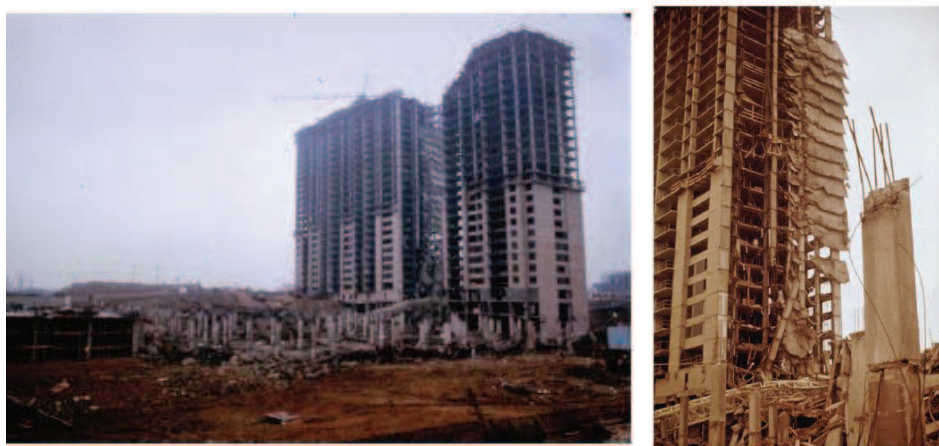
Rys. 1.1. Widok na zniszczony wieżowiec i przyległy parking [118]
