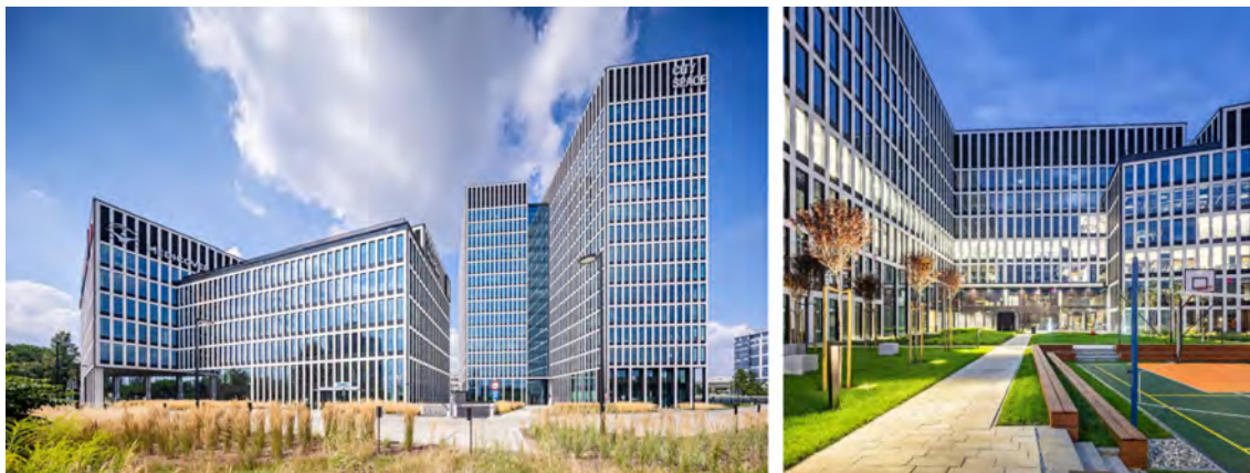
Il. 82, il. 83. Face 2 Face, kompleks biurowy Echo Investment Katowice Źródło: materiały własne Grupa 5 Architekci.
