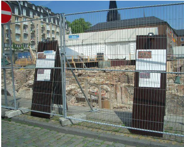
Fot 7. Ogrodzenie terenu prac rekonstrukcyjnych dzielnicy żydowskiej w centrum Kolonii.
