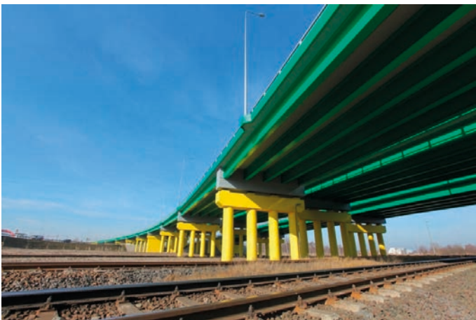
Rys. 1. Wiadukty WD-7 oraz WD-8 na Trasie Sucharskiego w Gdańsku [7]
