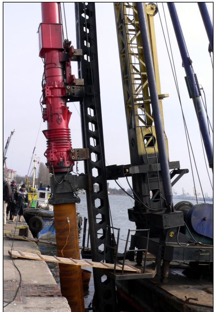
Rys. 16. Badanie dynamiczne PDA podczas wbijania pali rurowych (kafar z młotem typu Delmag zainstalowany na pontonie)
