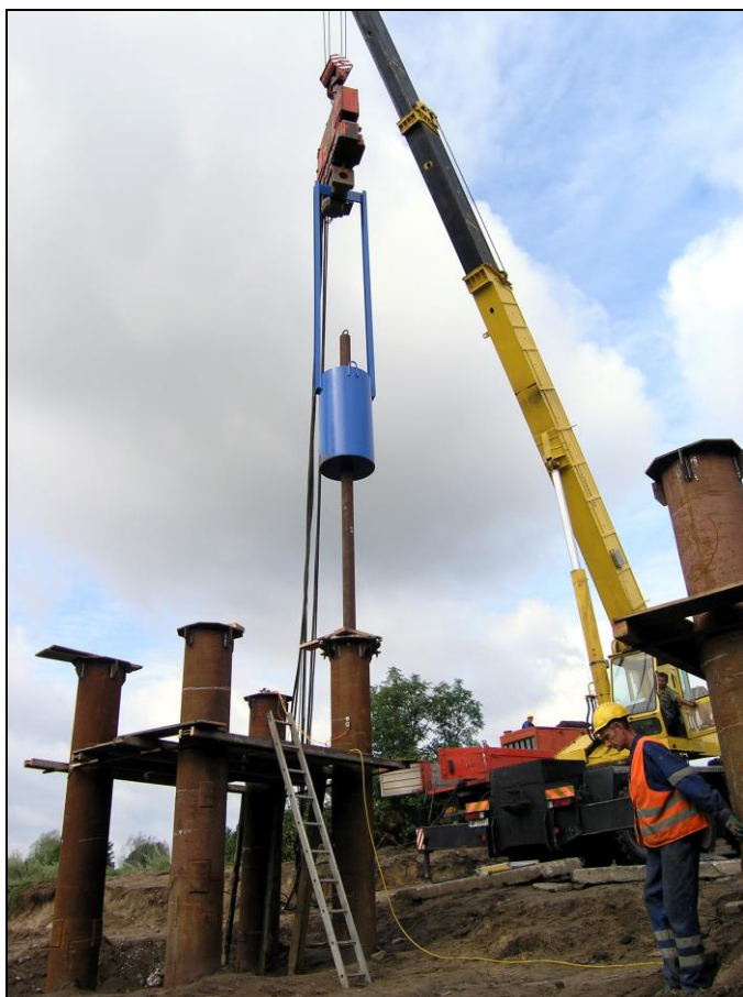
Rys. 12. Badania dynamiczne nośności pali rurowych \phi 508/11 mm z dnem otwartym
