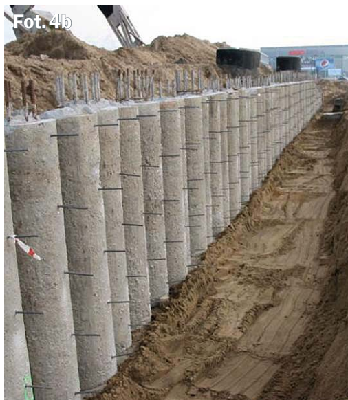
Palisada ażurowa z pali CFA Odcinek 1: średnica pali – 430 mm, długość – 4,5 do 7,5 m, rozstaw osiowy – 0,6 m Odcinek 2: średnica pali – 630 mm, długość – 8,5 do 11 m, rozstaw osiowy – 0,8 m Odcinek 3: średnica pali – 800 mm, długość – 12 do 13 m, rozstaw osiowy – 0,9 i 1 m Głębokość wykopu: od 3 do ok. 5,7 m
