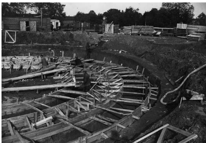
Rys. 8. Szalowanie fundamentów pod zbiornik „Obluże” (ze zbiorów MMG-HM-II-521-17)
