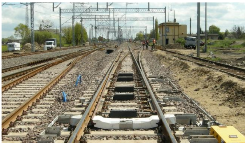
Fot. 1. Rozjazd zwyczajny prawy o promieniu 760 m
