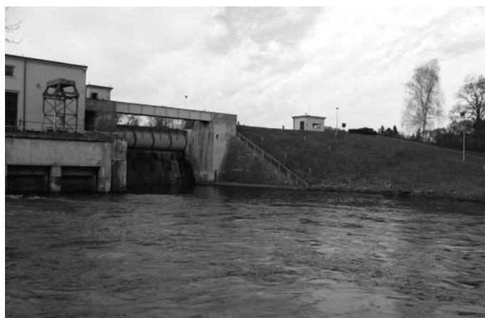
Rys. 6. Ogólny widok stopnia wodnego Smukała i remontowanej przyzmy drenażowej
