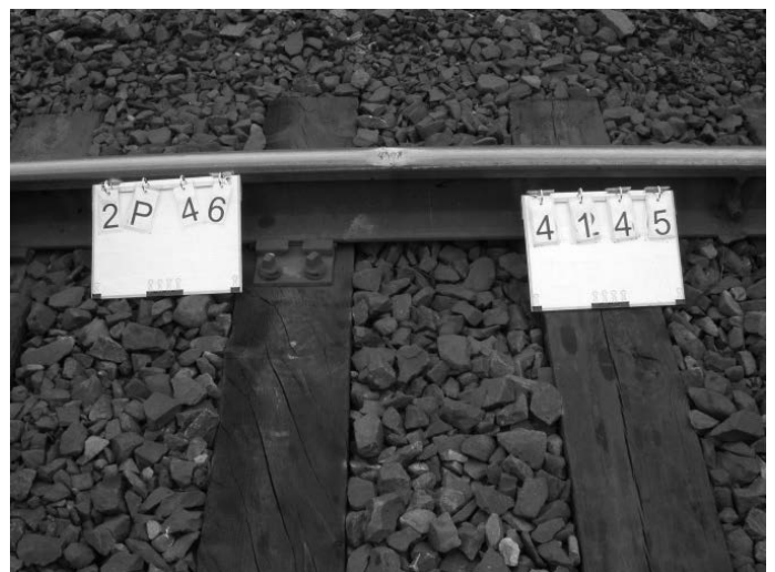
Rys. 8. Wada squat – brak przytwierdzenia szyny do podkładu
