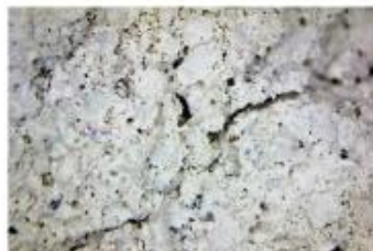
FOT. 9. Struktura tynku – widok tynku ciepłochronnego (perlitowego); powiększenie 40-krotne; fot.: autorzy
